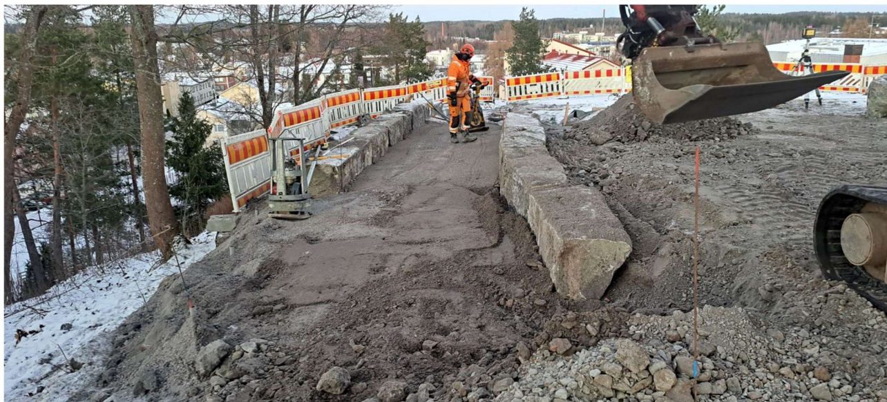
Kuva 9. Sokkelikivien uusiokäyttöä Naisvuorella 2024
